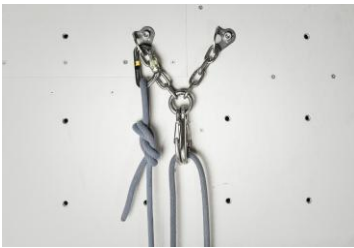
Fiksering i bolt – tilbageføring gennem anker
